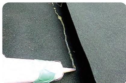
被着面の汚れ・埃を除去し接着剤を塗布して圧着してください（塗布量は10cm×10m当たり500gを目安）
