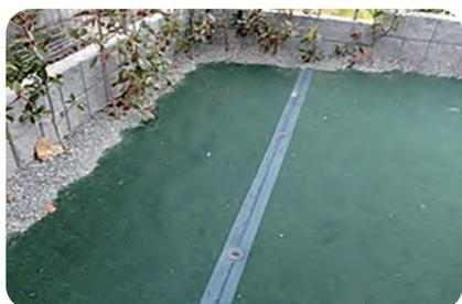
被着面の汚れ・埃を除去し、テープを貼り付けてください（シート同士の重ね代は10cm以上）
