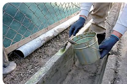
被着面の汚れ・埃を除去し接着剤を塗布してください（塗布量は10cm×10m当たり500gを目安）
