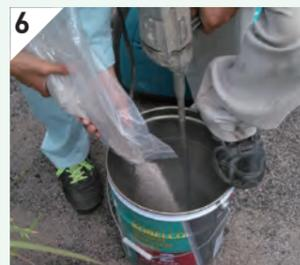
袋の中で珪砂をよく混ぜ、工程5の混合物に入れしっかりと攪拌します。
