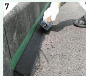
左官ゴテを使いしっかりと押さえ、左官仕上げをしていきます。しっかりと傾斜を付けて施工します。
