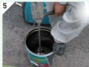
専用ウレタン樹脂1kgと着色剤100gを混合します。セットのプラバケツを使う際は半分の量で混合して施工ください。ヘラでも混ぜますが、攪拌用の工具の利用をお勧めします。
