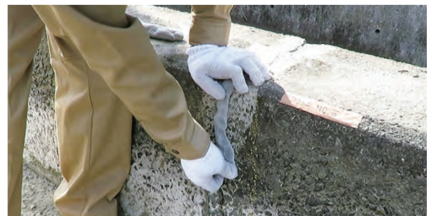
コンクリートのひび割れ補修
