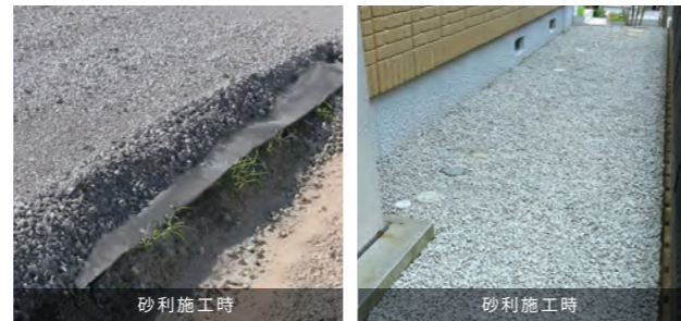
砂利施工時 砂利施工時
