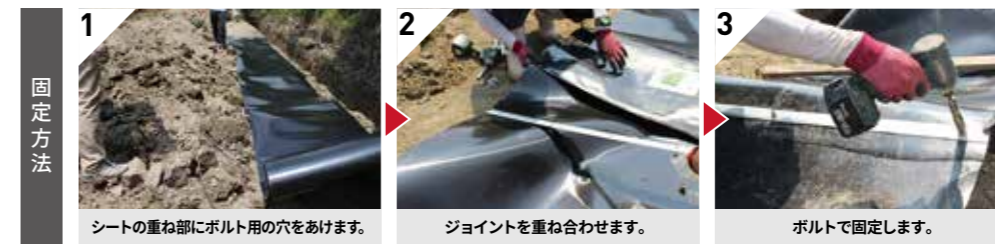
シートの重ね部にボルト用の穴をあけます。
