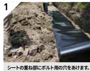
シートの重ね部にボルト用の穴をあけます。
