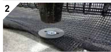
フェンス足元の処理
