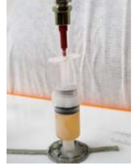
追い打ち注入の様子
