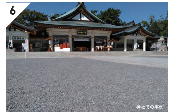
6 完成 e-レスターが露出していないか、不陸がないかチェックして、必要に応じて整地してください。
