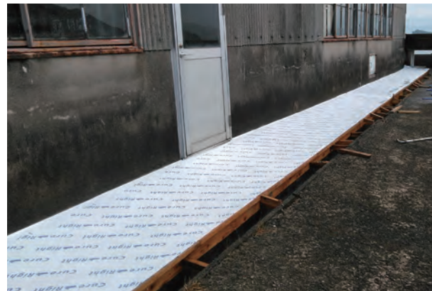
建物の犬走り
