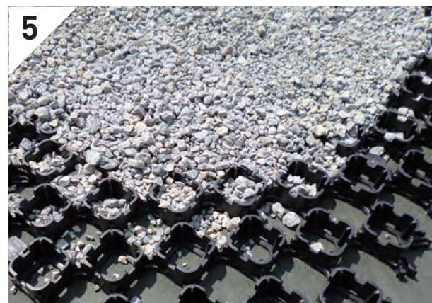
5 砂利充填 レーキなどを使用し、均一に満遍なく広げてください。
