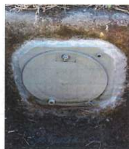
↑ 施工後 (分水栓)
